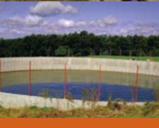
L'**entreposage étanche** du fumier et du lisier évite tout écoulement dans l'environnement. Le plus souvent, il s'effectue en utilisant un réservoir de béton situé près des bâtiments de ferme.
